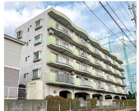
従業員が増え移転した3代目事務所
